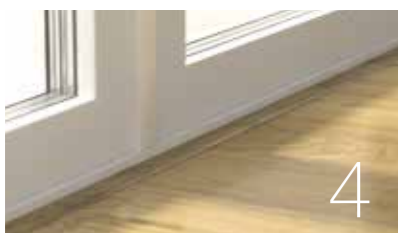
Junta de terminación Terminación hasta el umbral de las puertas, puertas correderas, etc.
